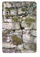
Die vertikalen Fugen zwischen den Steinen verlaufen übereinander und nicht versetzt, sowohl in der Länge als auch in der Dicke der Mauer (struktureller Schwachpunkt), und verringern den Zusammenhalt und damit die Festigkeit der Mauer insgesamt.
