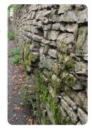
Die Mauer weist einen gewölbten Bereich auf, der die gesamte Mauerstärke betrifft oder nur die Sichtfläche, die sich vom Rest des Bauwerks löst.
